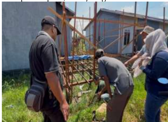
Gambar 5. Proses penggalian, perbaikan, dan normalisasi pipa induk
