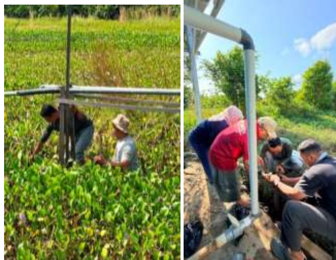
Gambar 4. Pemasangan dua unit pompa air
