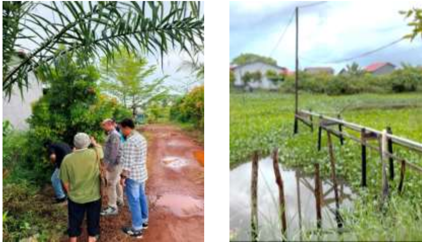
Gambar 1. Kondisi awal infrastruktur dan peninjauan jaringan air bersih Desa Sukabaru
