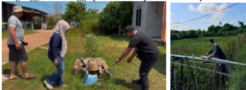
Gambar 2. Proses penelusuran dan perbaikan jaringan perpipaan
