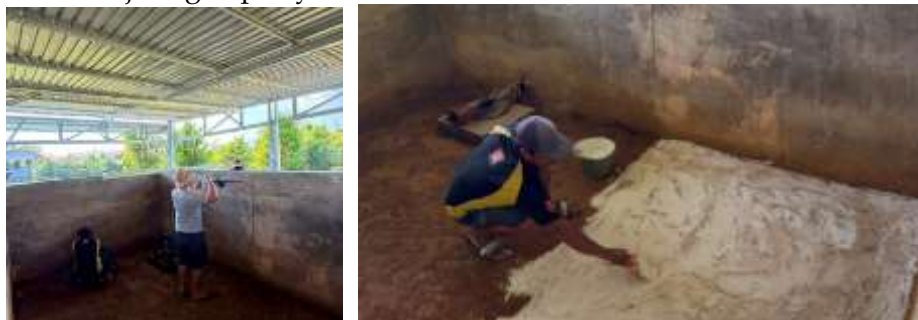
Gambar 3. Perbaikan dan pelapisan bak penampung air
